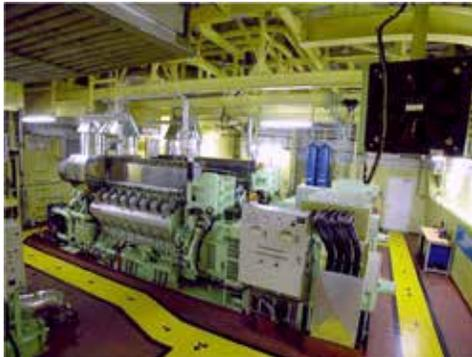
Gerador de energia em uma plataforma de petróleo off-shore. A um longo caminho de casa, a confiabilidade do sistema é fundamental.
